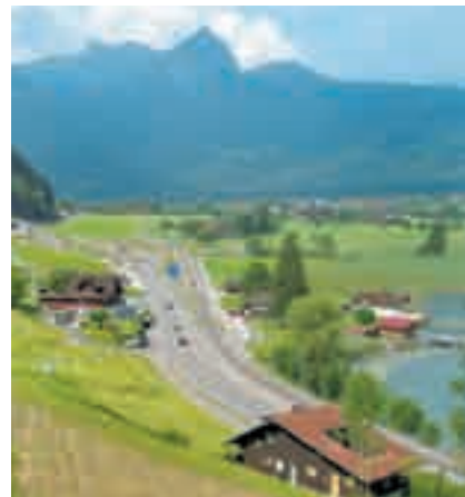
Gelände vor Baubeginn, 2006
