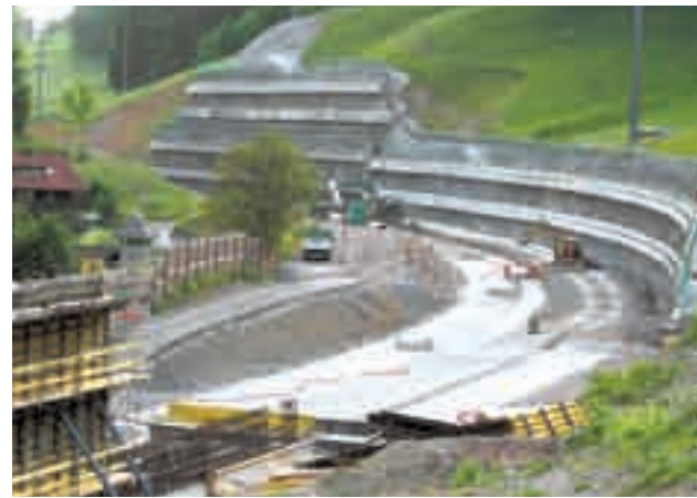
Bohrpfahlwand, Mai 2008, Höhe bis 20 m
