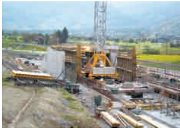
Start der Betonarbeiten Tunnel, Mai 2008
