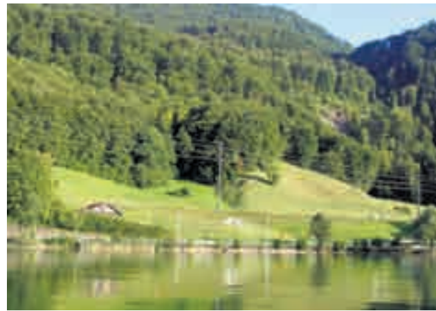
Harmonische Eingliederung Tunnel in Landschaft
