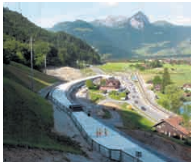
Stand Tunnelbau, Juni 2009
