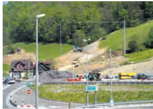
Beginn der Erdarbeiten, April 2007
