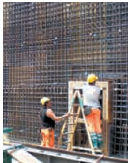
Armierung der Tunnelwände
