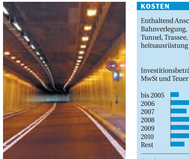
Tunnelröhre vor Eröffnung
