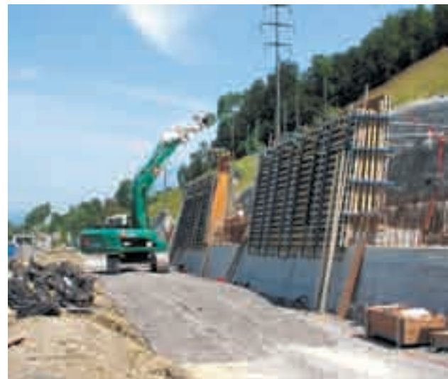
Bau der Stützmauer, Juni 2009
