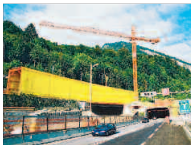
Bahnschutzunnel über neuem Tunnelportal.
