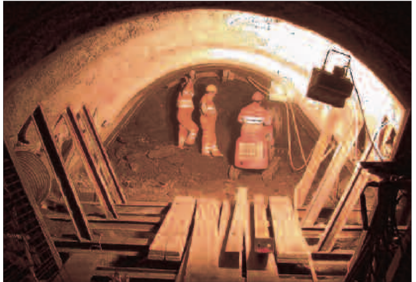
Firststollen über Erkundungsstollen mit Stahleinbau gesichert.
