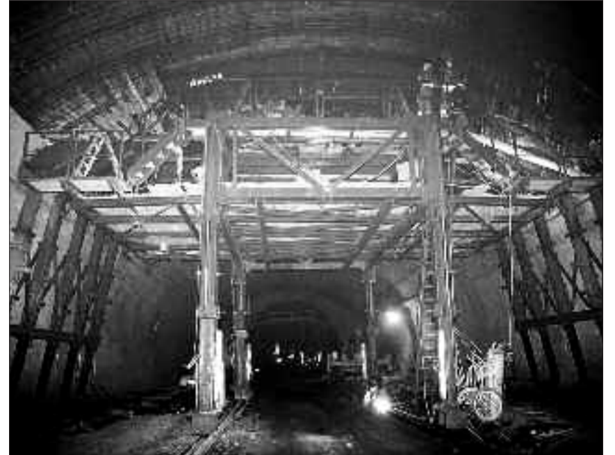
Betonschalung für Kalotte in der Ausstellnische.
