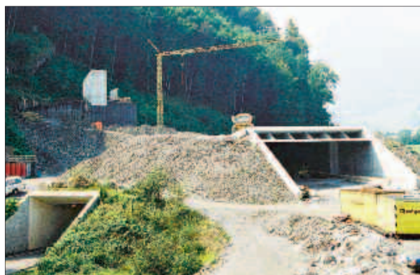
Nordportal Tunnel Giswil mit Abluftkamin.
