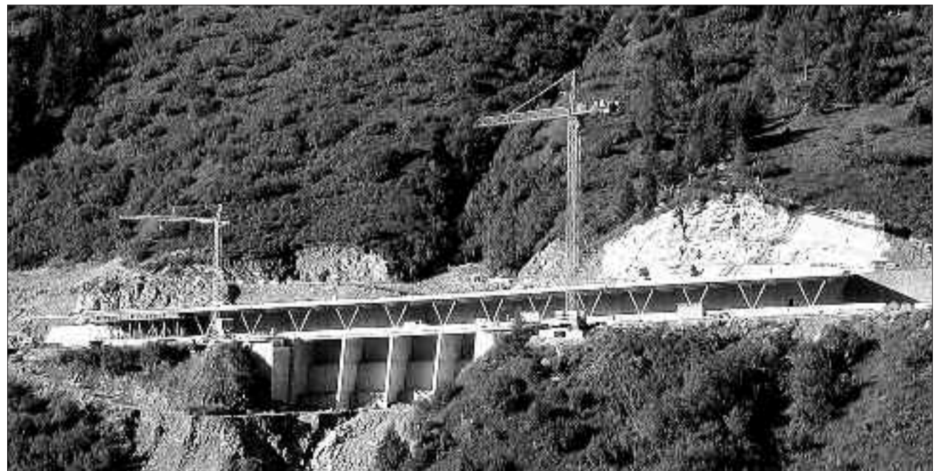
Lawinengalerie Ri di Rialp, Lukmanierpassstrasse.
