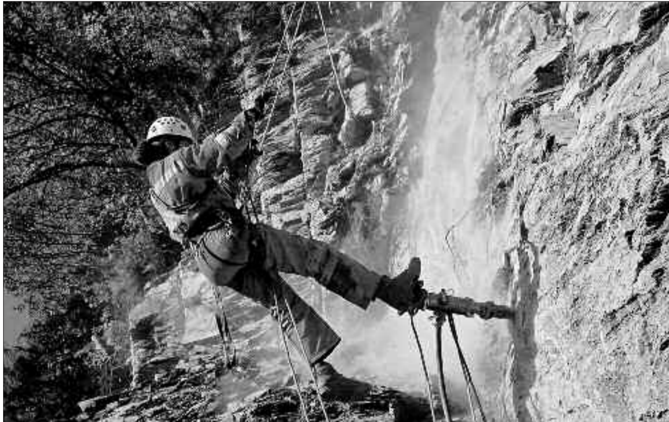
Akrobatische Steinschlagschutz-Arbeiten oberhalb der Brünigpassstrasse.
