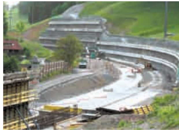
Bohrpfahlwand, Mai 2008, Höhe bis 20 m
