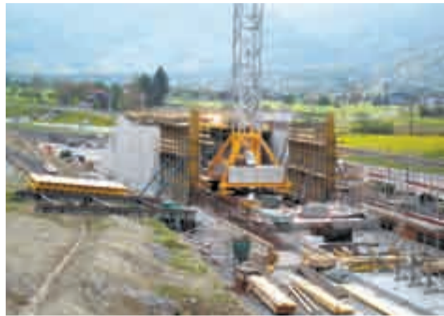
Start der Betonarbeiten Tunnel, Mai 2008
