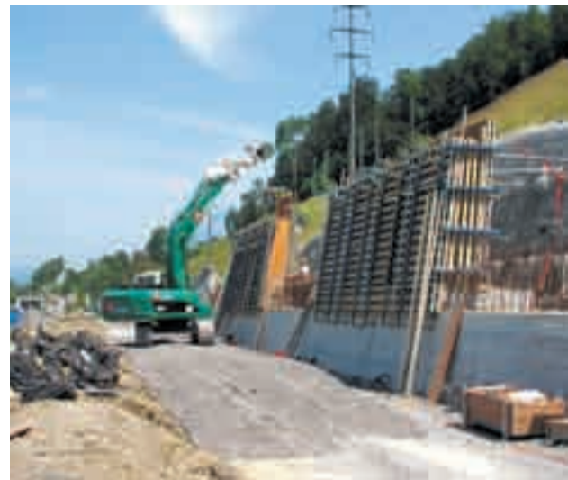
Bau der Stützmauer, Juni 2009
