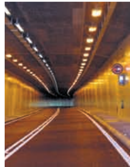
Tunnelröhre vor Eröffnung
