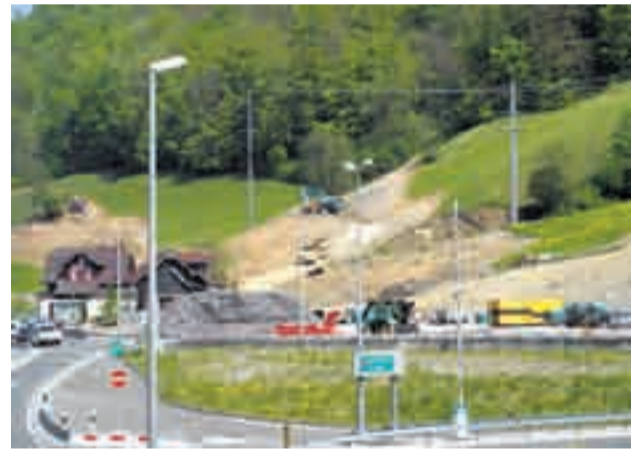
Beginn der Erdarbeiten, April 2007
