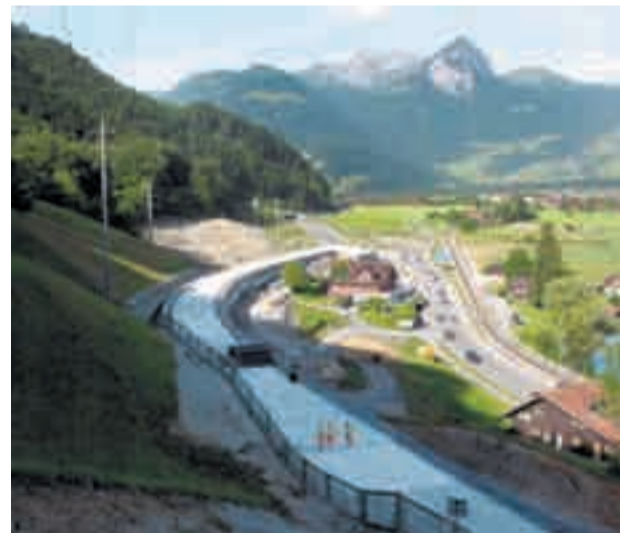
Stand Tunnelbau, Juni 2009
