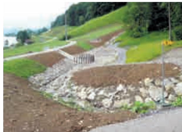
Geschiebesammler oberhalb Tunnel
