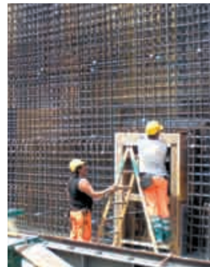
Armierung der Tunnelwände
