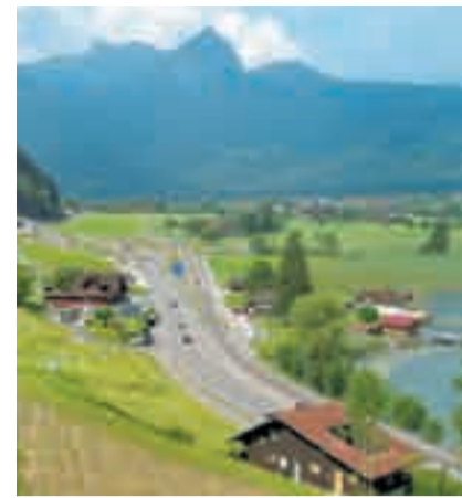
Gelände vor Baubeginn, 2006
